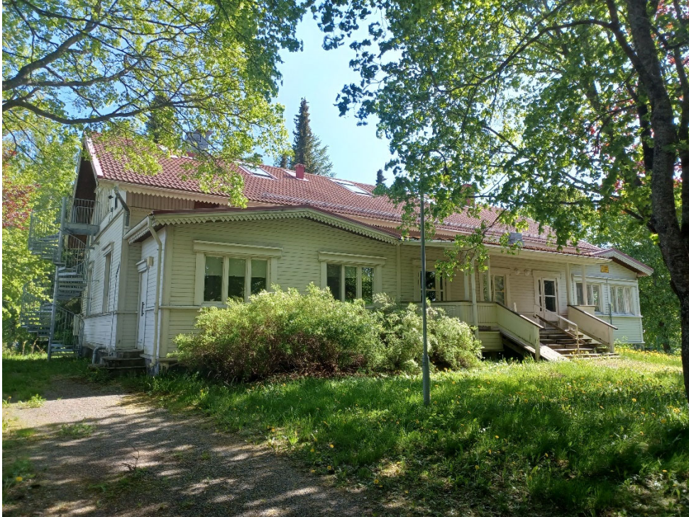
Kuva 4. Kuva Alakartanon päärakennuksesta.
